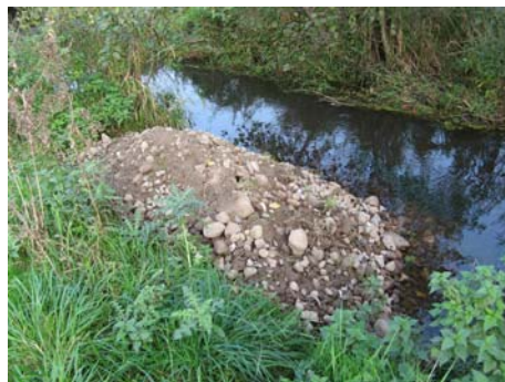
(4) Kiesschüttung als Seiteneinengung im Staersbach
