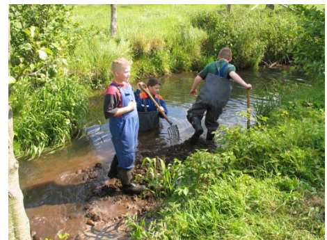
(5) Beim Einbringen von Kies in das Gewässerbett
