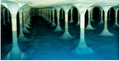
(1) Trinkwasserbehälter im Forstenrieder Park / München. In zwei Kammern können bis zu 130.000 m 3 Wasser gespeichert werden
