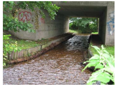
(8) Eine raue Kiessohle und beidseitige Bermen verbessern die Passage unter einer Brücke
