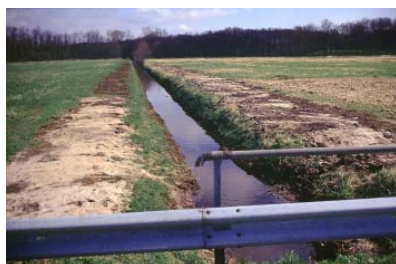
(4) Harte Gewässerunterhaltung, Landnutzung bis ans Ufer heran und fehlende Uferandpflanzen führen zu starker Erosion und Sandeintrag
