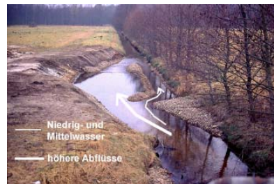
(5) Ein Sandfang hält Erosionsmaterial zurück, der Erlensaum beschattet den Gewässergrund, verhindert Massenwachstum von Wasser- und Sumpfpflanzen und schützt das Ufer
