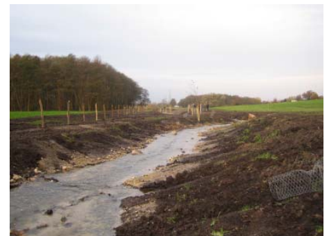
Renaturierungsbaumaßnahmen am Fulgenbach
