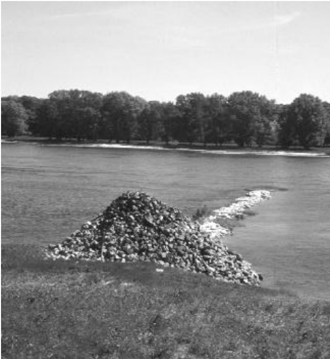
Buhnen- „Instandsetzung“ an der Elbe bei Lenzen: geht es nach dem Willen der Wasser- und Schifffahrtsdirektion, ähnelt die Elbe bald eher einem Kanal als einem Biosphärenreservat und Kulturerbe der UNESCO.
