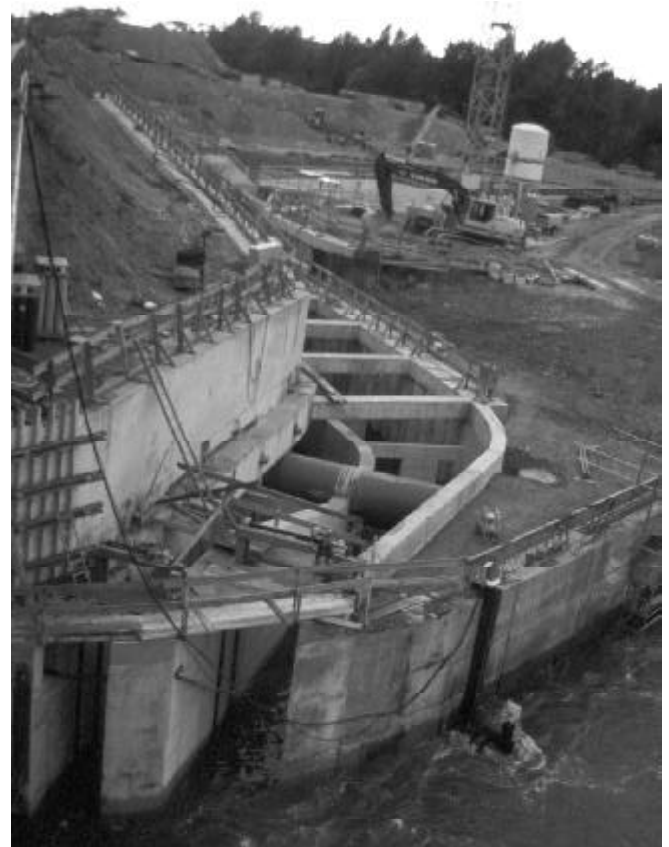
Fischtreppe an der Staustufe Iffezheim am kanalisierten Rhein: mit großem baulichen und finanziellen Aufwand wurde hier die biologische Durchgängigkeit für Wanderfische, wie dem Lachs, wieder hergestellt. Andere Auswirkungen der Staustufe können allerdings kaum vermieden werden.
