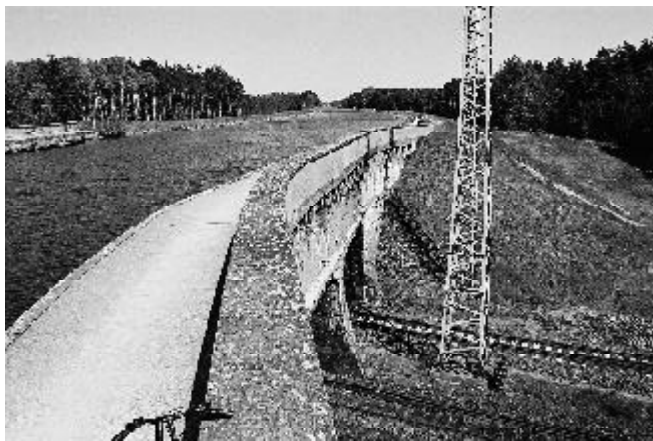
Eindeutig künstliches Gewässer: Oder-Havel-Kanal bei Eberswalde, hier die Trogbücke über die Eisenbahnlinie.
