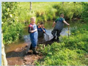
Einbringen von Kies in das Gewässerbett
