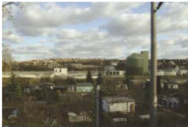
Die menschliche Nutzung des Wassers verändert dessen natürlichen Kreislauf: so wird zum Beispiel Trinkwasser aus Grundwasser gewonnen, nach der Nutzung in Kläranlagen wiederaufbereitet und dann in Oberflächengewässer eingeleitet. Nach der Wasserrahmenrichtlinie soll aus dem Grundwasser nicht mehr Wasser entnommen werden, als sich neu bildet.
