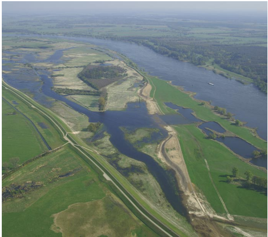
Deichrückverlegung an der Elbe bei Lenzen: Ein wegweisendes Projekt zur Verknüpfung von Hochwasserschutz, Gewässerentwicklung und Naturschutz an Bundeswasserstraßen. (Foto: ©Katharina Nagel, BUND / Trägerverbund Burg Lenzen e.V.)
